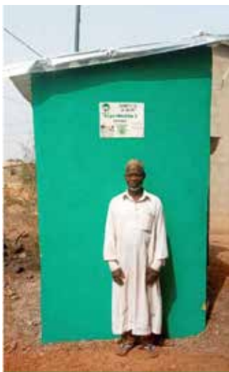
Latrine familiale à Kom'dé, Ouaké
