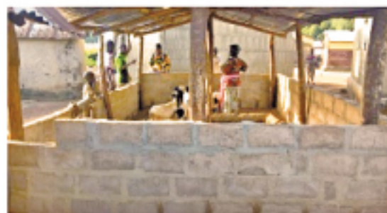
Enclos d'élevage réalisé en matériaux définitifs
