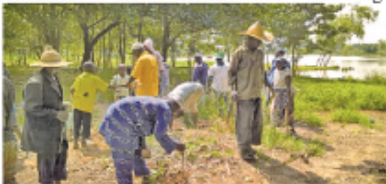
Mise en terre de vétiver autour du barrage de Kom'dè
